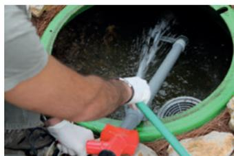
passer un coup de jet sur les cellules situées à l'autre extrémité dans une partie transparente. Vérifier que le signal est repassé au vert, la canne étant toujours à l'extérieur des effluents.
